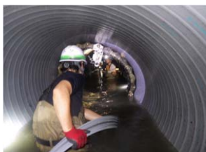
(現場)ベトナム初となる老朽埋設管の非開削での更生
