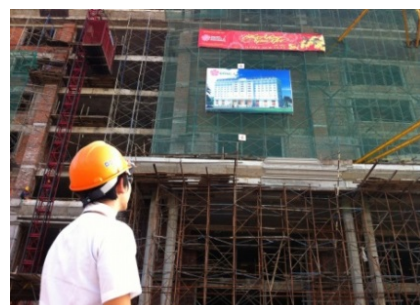
建設中の大学を視察し、関係者から話を聞く
